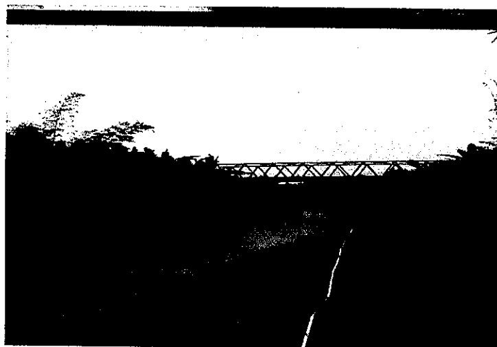
Gambar 40. Jembatan Kudu yang terdapat pada Sungai Babon
