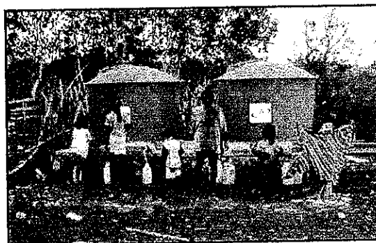
Gambar 5.6 FASILITAS AIR BERSIH DESA UMAKLARAN
