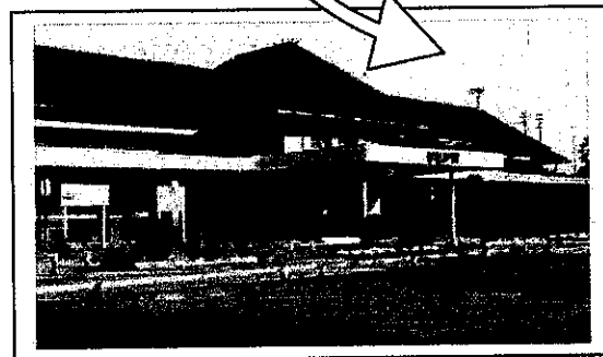
Bentuk bangunan Stasiun Kereta Api yang terletak di Kompleks perumahan PT KAI dengan gaya indish
