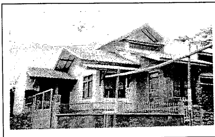
GAMBAR 4.18. KONDISI RUMAH YANG SUDAH DIRENOVASI TETAPI SUDAH PINDAH TANGAN
